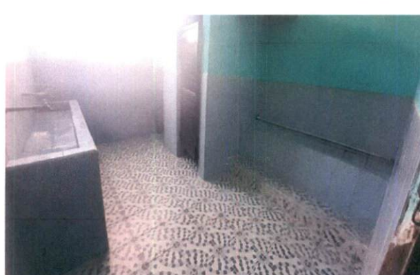
Foto 4: Reozamiento de servicios sanitarios
