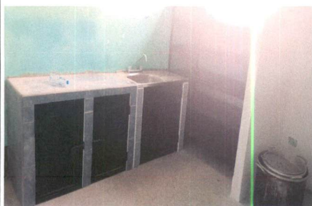
Foto 1: Remozamiento de cocina con estufa lorena y gabinetes
