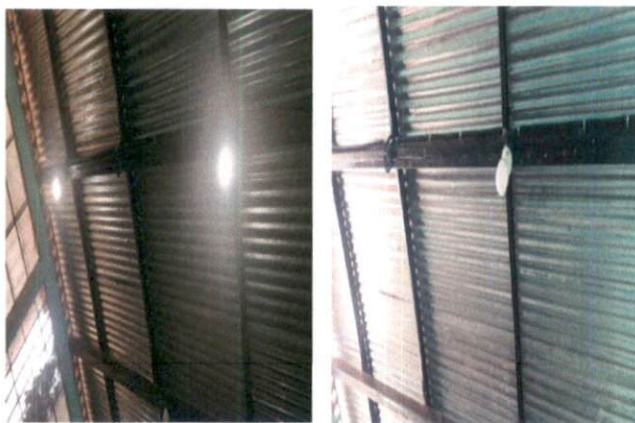
Foto 2: Remozamiento de luz electrica
