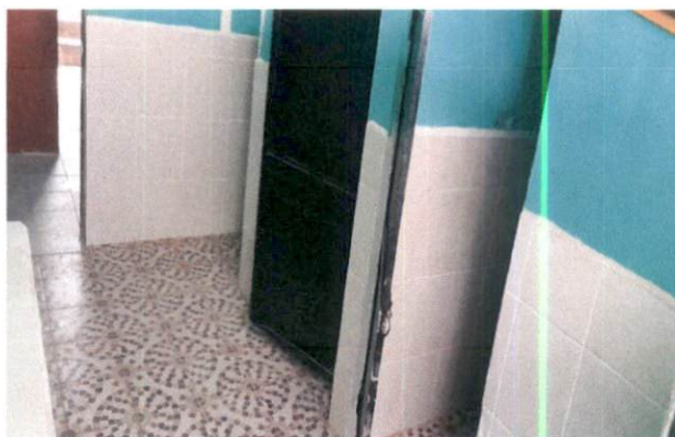
Foto 3: Remozamiento de servicios sanitarios
